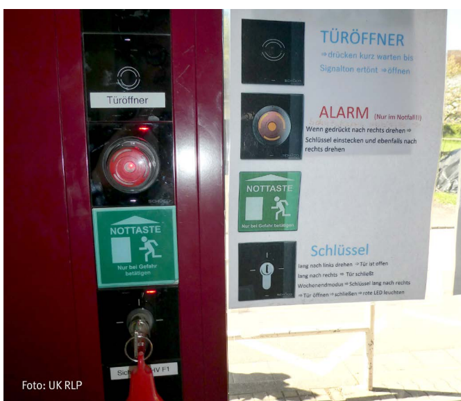
Elektrische Türsicherung
