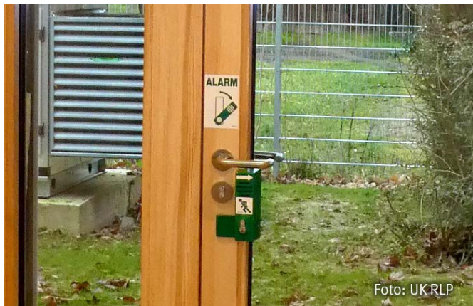
Bild 1: Notausgangstür mit Alarmsicherung
